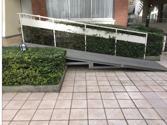
⑥ I館スロープ(1)
