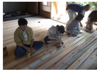
写真3 杉板張り替え
