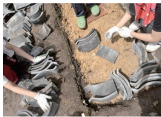
写真2 瓦の木端立て
