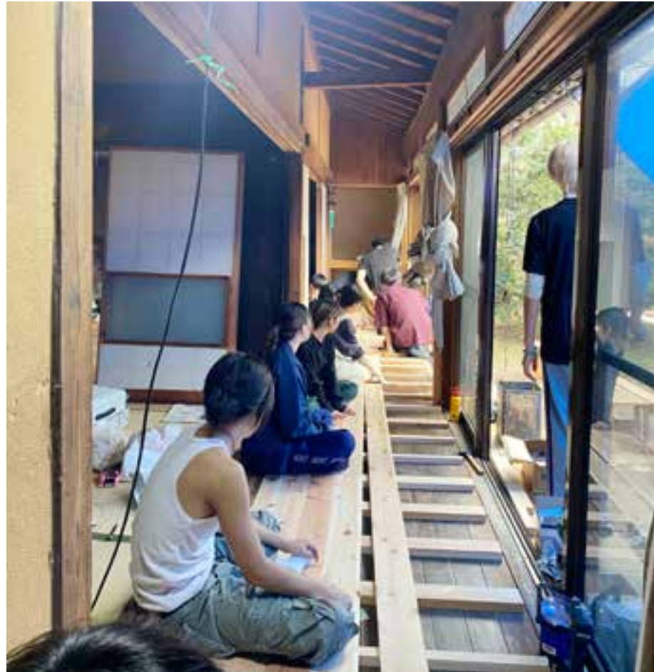
南側縁側の古い縁甲板の上に杉のフローリング材を張る
