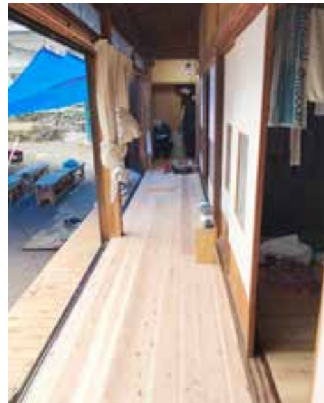
突き当りの押し入れを解体して新たな動線を生み出す
