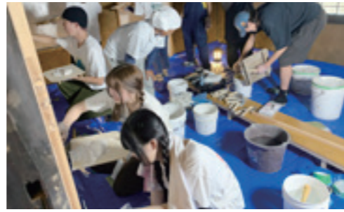
古民家改修（鏝絵制作）
